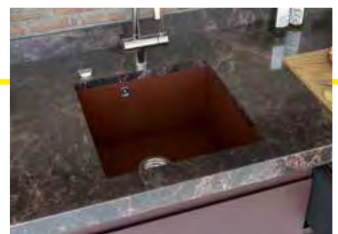
INSTALACIÓN BAJO ENCIMERA
